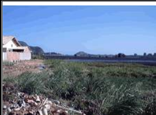
Foto 3- Construção sobre área aterrada na Laguna de Itaipú
