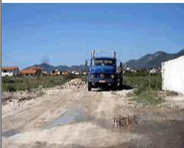
Foto 5 – Caminhão de aterro.
